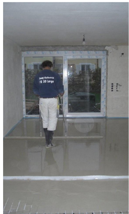
Nachbearbeitung der eingebrachten Nivelliermasse N 440 mittels Schwabbelstange
